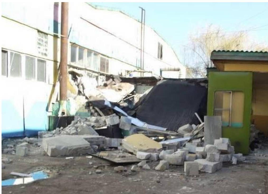
9). 27.03.2016 в мини-котельной (3x8 м), пристроенной к административно-бытовому корпусу ДКУСП «Глубокская ПМК-48» (ул. Озерная, 8, г.п. Подсвилье, Глубокский район, Витебская область) произошел разрыв отопительного котла на твердом топливе. В результате разрыв котла разрушено две стены в мини-котельной, повреждена кровля. Пострадавших нет. Предполагаемая причина разрыва – отсутствие циркуляции воды в системе.
