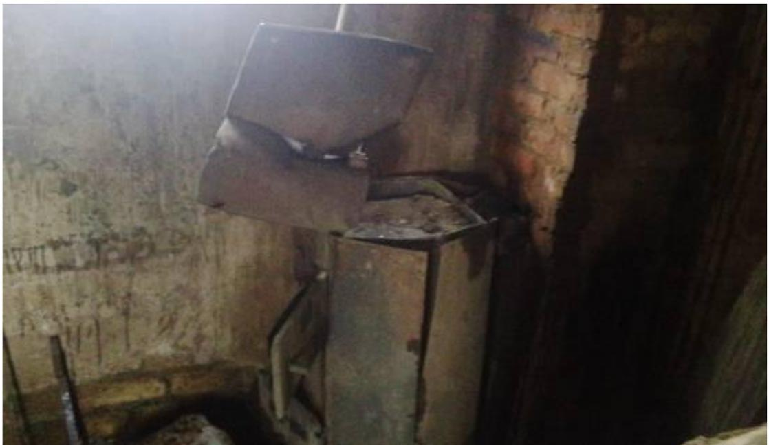
2). 06.01.2016 в помещении мини-котельной (3x4 м) жилого дома (ул. Уютная, г. Рогачев, Гомельская обл.) произошел разрыв отопительного котла. Пострадавших нет. Причина разрыва котла – отсутствие циркуляции воды в системе.
