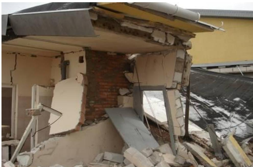
8). 26.03.2016 в мини-котельной (5х6 м) на территории филиала «Автобусный парк № 2» ОАО «Гомельоблавтотранс» (г. Мозырь, Гомельская область) произошел разрыв отопительного котла на твердом топливе. В результате разрыва котла произошло обрушение железобетонных плит перекрытия. Пострадавших нет. Предполагаемая причина разрыва – отсутствие циркуляции воды в системе.
