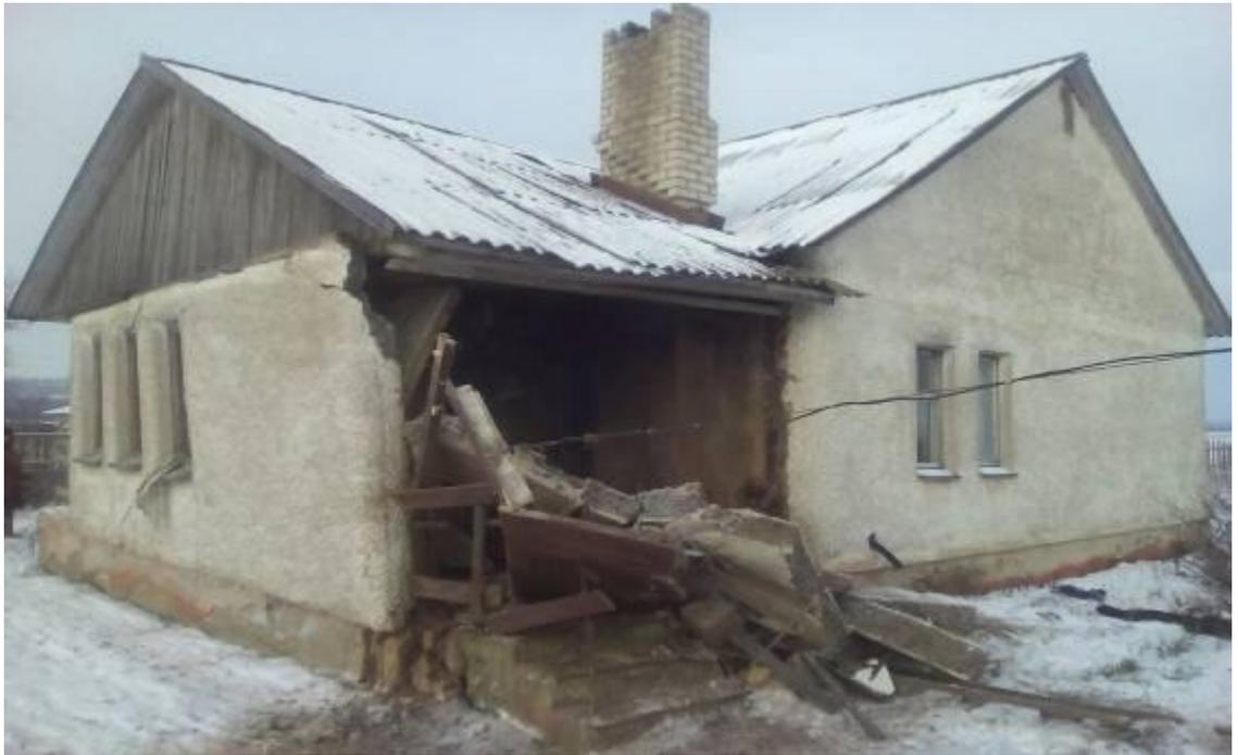
4). 07.01.2016 в помещении мини-котельной (3х3 м) жилого дома (ул. Бранкевича, г. Миоры, Витебская обл.) произошел разрыв отопительного котла. В результате разрыва котла разрушена стена топочной, повреждена кровля. Пострадавших нет. Причина разрыва котла – отсутствие циркуляции воды в системе.
