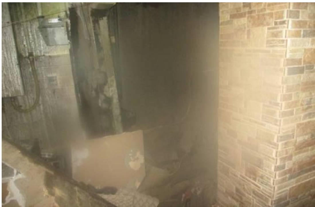
6). 06.02.2016 в помещении кухни (2х3 м) жилого дома (2-й пер. Маличевского, г. Жлобин, Гомельская обл.) произошел разрыв отопительного котла на твердом топливе. Хозяйка жилого дома была госпитализирована с ожогами 1-3 степени (20 % тела). Причина разрыва котла – отсутствие циркуляции воды в системе.
