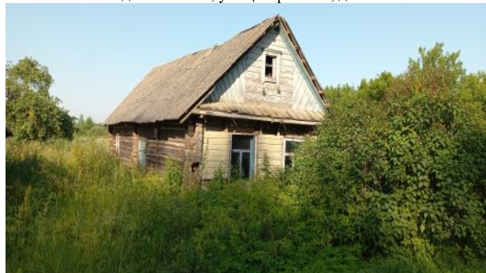
д.Ковшелево, ул. Центральная, д.52 А
