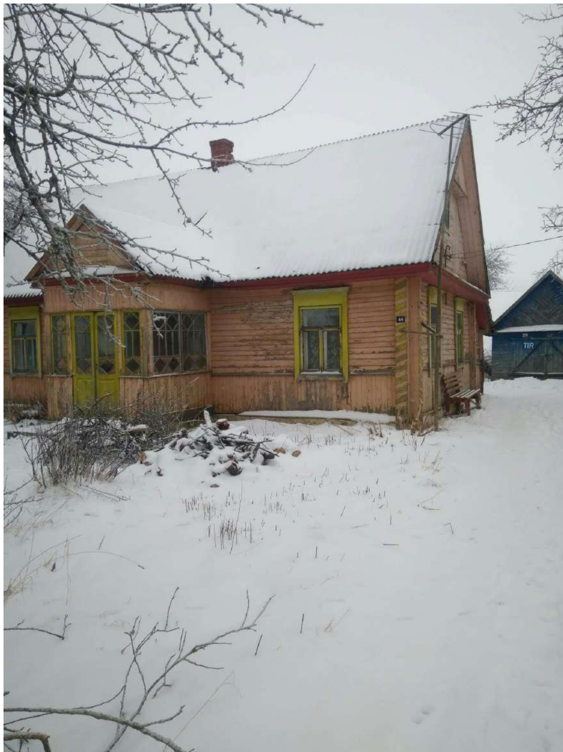
д. Саутки, ул. Центральная, д.44
